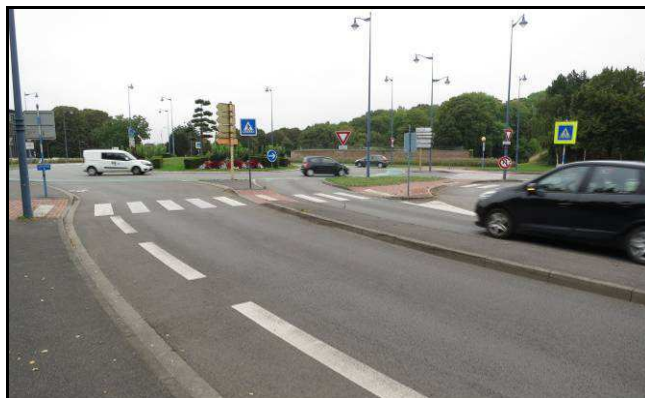
Giratoire aux portes du centre-ville d'Arras, dont toutes les branches sont à 2 x 2 voies (plus un tourne-à-droite direct pour certaines d'entre elles)
