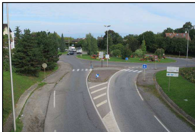
Traversée d'un boulevard à fort trafic au niveau d'un giratoire (Thonon)
