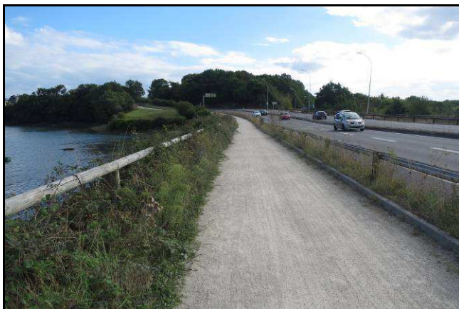
Voie cyclo-piétonne sur le pont reliant Lorient à Larmor-Plage
