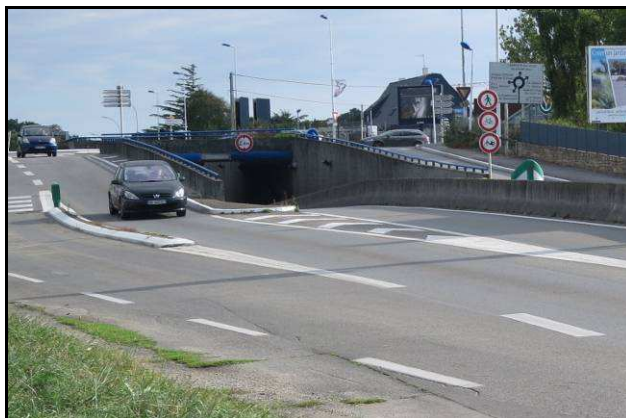
Route venant de Lorient, à l'entrée de Larmor-Plage
