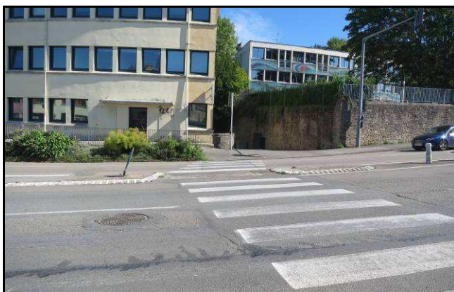
Traversée d'une 2 x 2 voies à un feu (Quimper)
