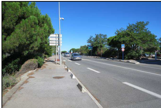
DN 7 aux portes du centre-ville de Fréjus
