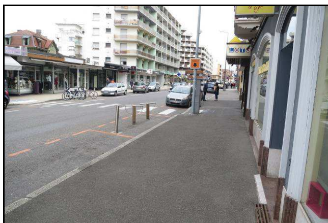
Large trottoir dans le centre de Thonon
