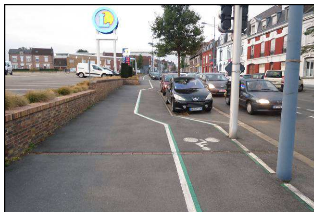
Piste cyclable sur trottoir (Arras)
