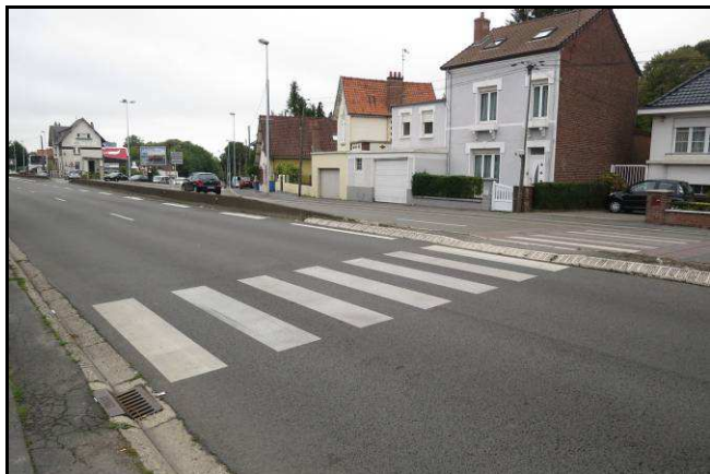
Traversée d'une 2 x 2 voies en section courante (Arras)
