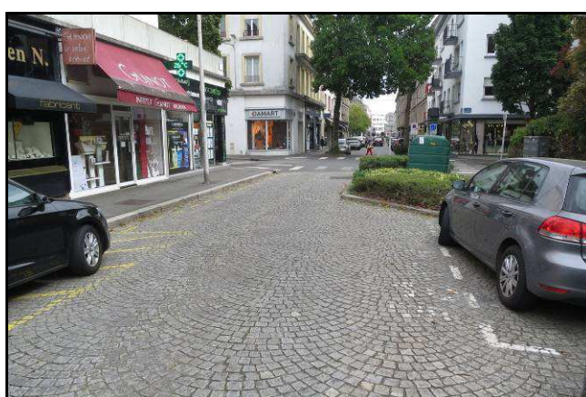
Rétrécissement de chaussée (Lorient)
