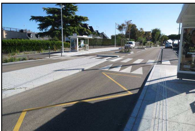
Dénivellation de chaussée au niveau d'un arrêt de bus 27
