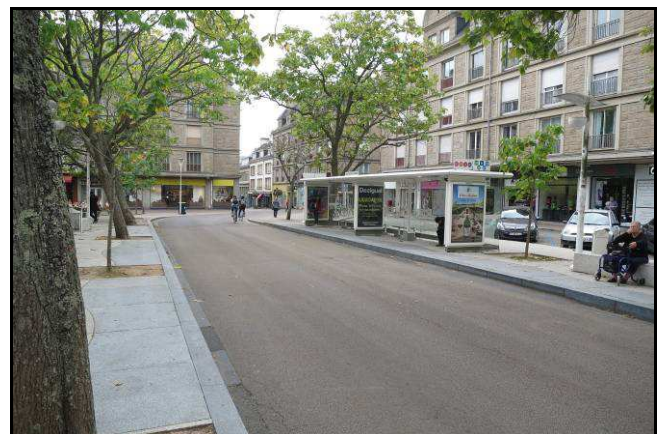
Site propre dans la zone piétonne de Lorient
