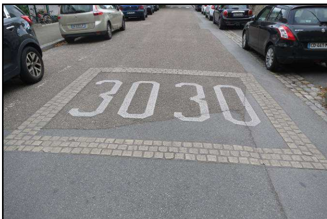
Pavage au sol en entrée de zone 30 (Lorient)
