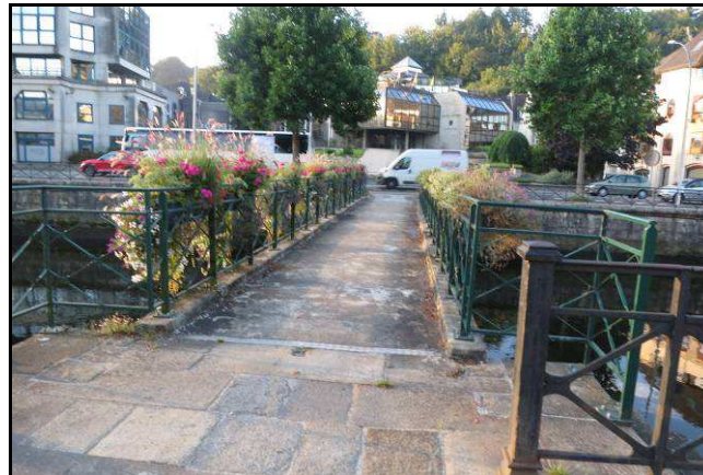
Passerelle sur l'Odet (Quimper)
