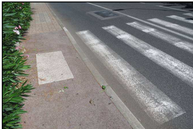
Traversée avec abaissé et dalle podotactile (Saint-Raphaël)
