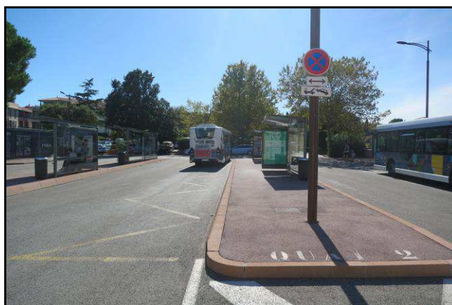
Gare routière de Fréjus (en bordure du centre-ville)
