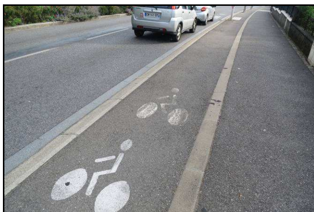
Piste cyclable unidirectionnelle à mi-hauteur de la chaussée et du trottoir (Thonon)
