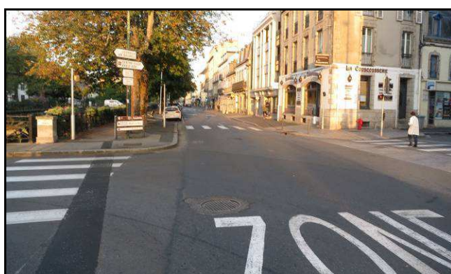
Entrée de zone 30 sur un boulevard du centre-ville sans aucun aménagement (centre-ville de Quimper)
