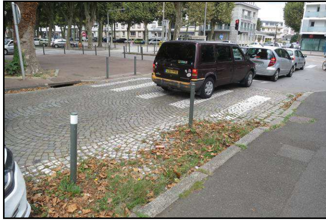
Neutralisation d'une place de stationnement automobile par deux potelets pour dégager la visibilité (Lorient)
