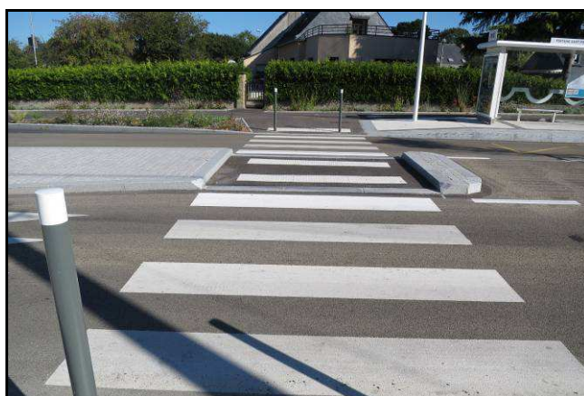
Traversée au niveau d'un arrêt de BHNS (Ploemeur)
