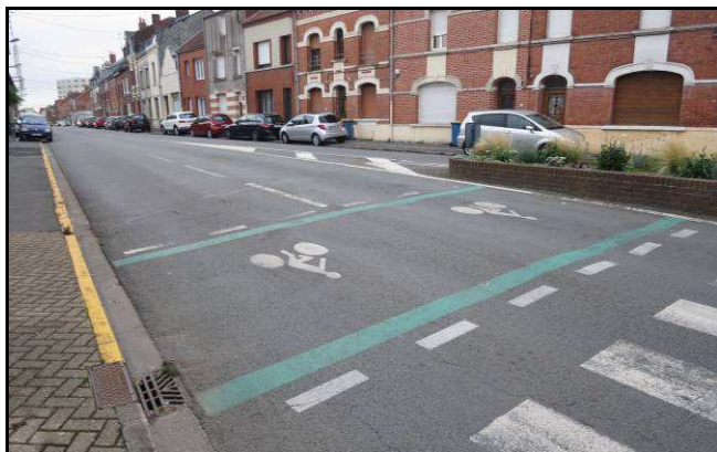
Sas à vélos (Arras)
