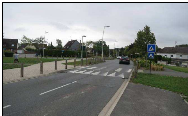
Passage piéton surélevé (Saint-Nicolas)
