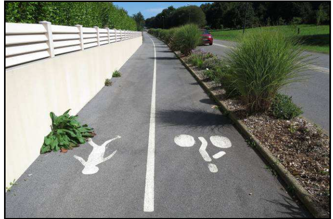
Voie verte (Pluguffan)
