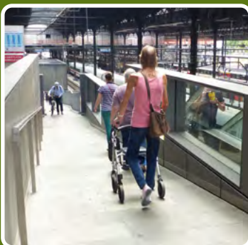
La rampe idéale aussi pour les autres usagers. Une goulotte assez large évite de coincer guidon et sacoches dans la main courante.
