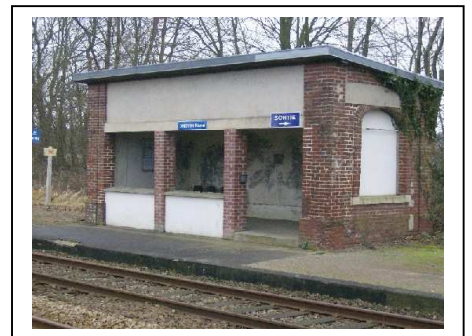
L'arrêt de Longuerue – Vieux Manoir : un arrêt peu pratique où les usagers subissent parfois les effluves de l'élevage voisin
